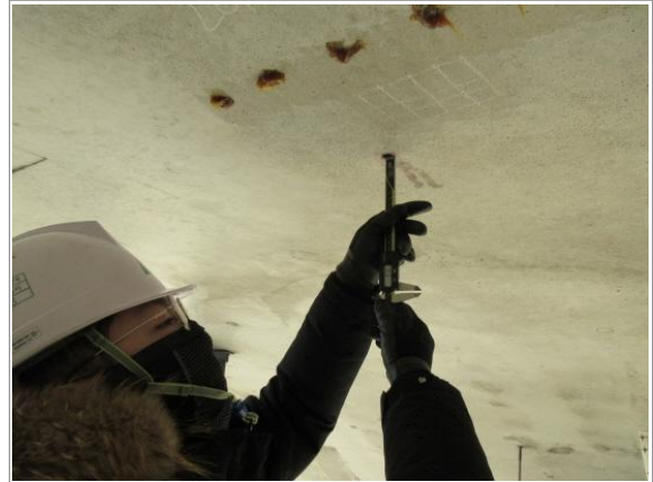
탄산화 깊이 측정 전경 ②
