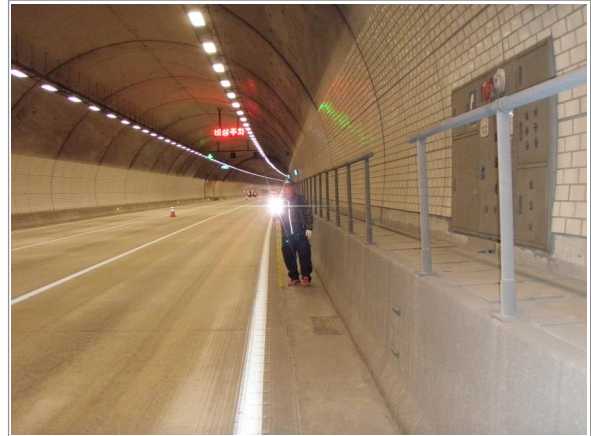
단면측량 전경 ②
