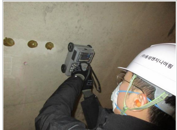
철근탐사시험 시험 전경②
