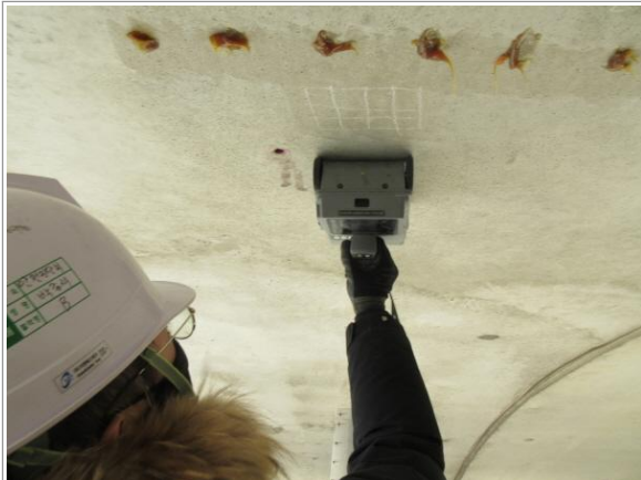
철근탐사시험 전경 ①
