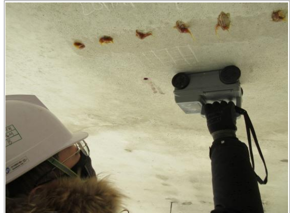
철근탐사시험 시험 전경 ②
