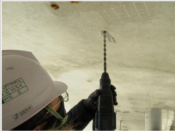
탄산화 깊이 측정 전경 ①
