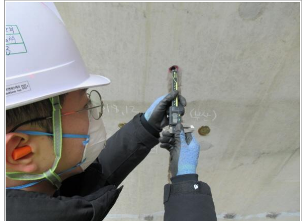
탄산화 깊이 측정 전경②
